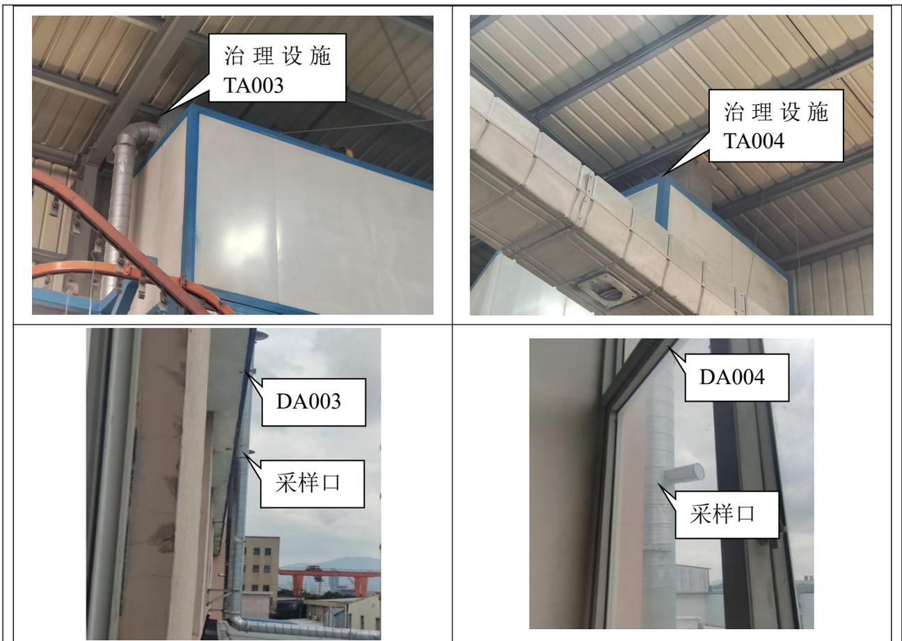
图 3-6 塑粉固化废气及液化石油气燃烧废气治理设施照片
