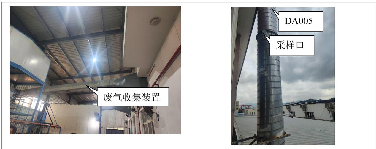
图 3-8 注塑粉尘治理设施照片
