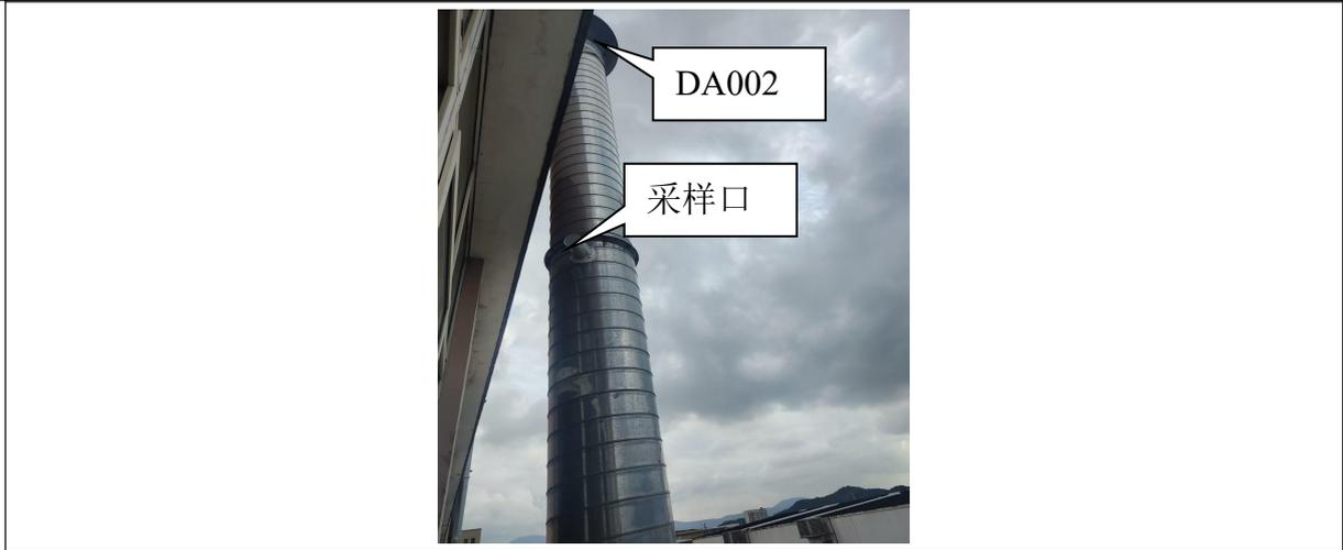
图 3-4 喷塑粉尘治理设施照片
